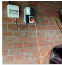
Laadpunt Mode 3: Nexxtender Wallbox Single van Powerdale
