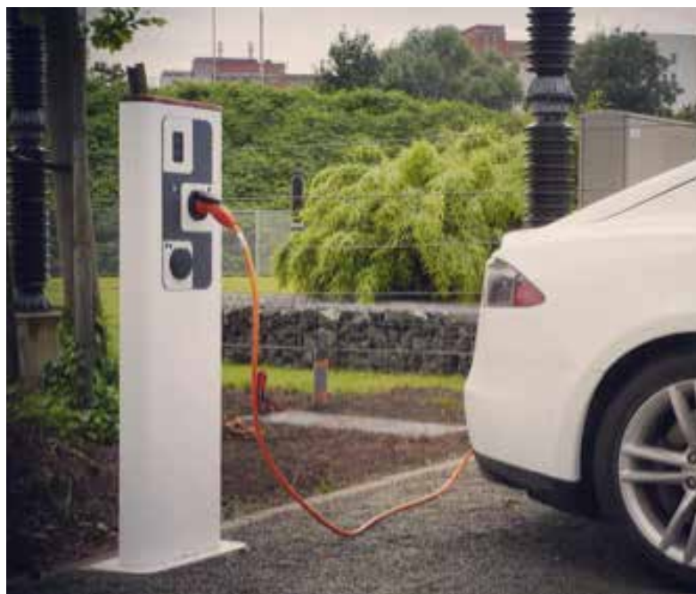
Point de recharge de mode 3 (point de recharge extérieur) : borne de recharge Nexxtender Dual de Powerdale
